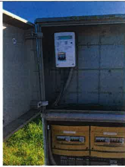
Particolare vano quadro di protezione e comando Polo Conciario
