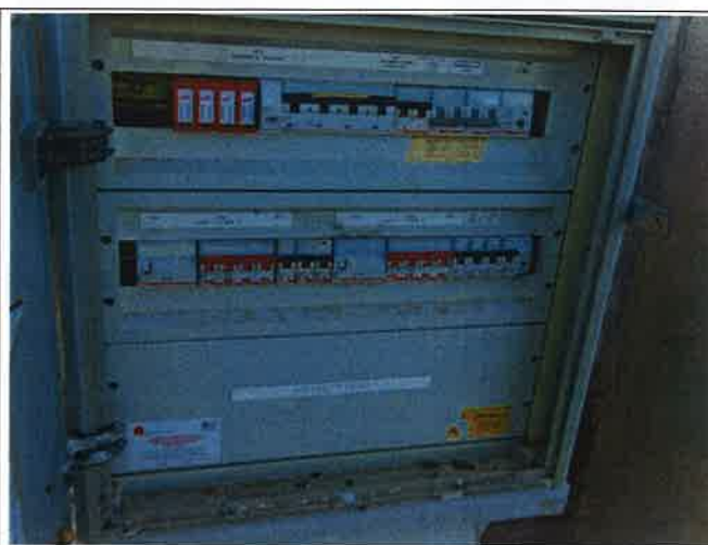
Particolare quadro di protezione e comando CAB A
