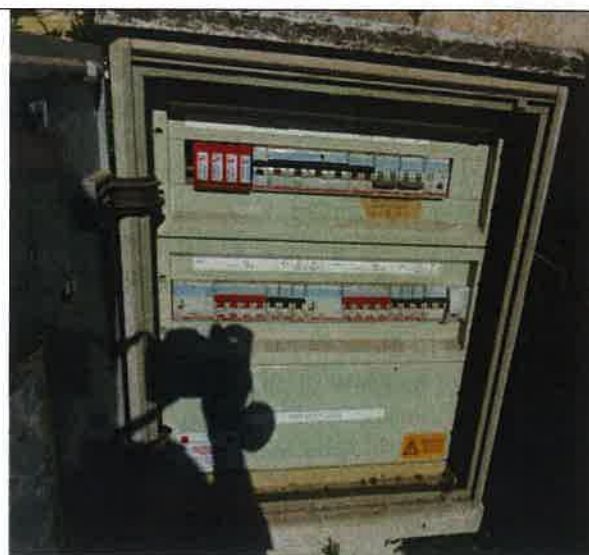
Particolare quadro di protezione e comando CAB A
